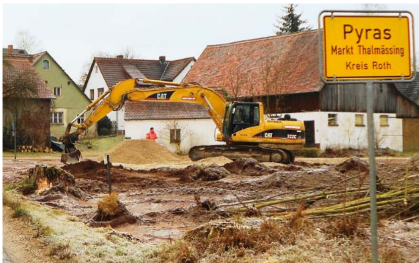
Es gibt viel zu tun: Für den Ausbau der Ortsdurchfahrt Pyras sind die Baumaschinen schon voll im Einsatz. Mit rund 7,3 Millionen Euro investiert der Landkreis heuer so viel in den Tiefbau wie die vergangenen zwei Jahrzehnte nicht.
