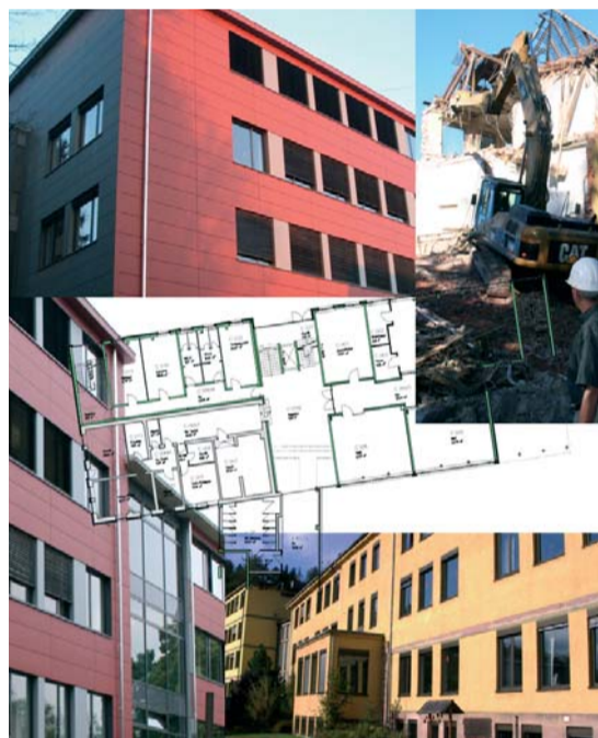
Umfangreiche Arbeiten wurden für den Neubau an der Realschule Roth in nur 400 Arbeitstagen verwirklicht
